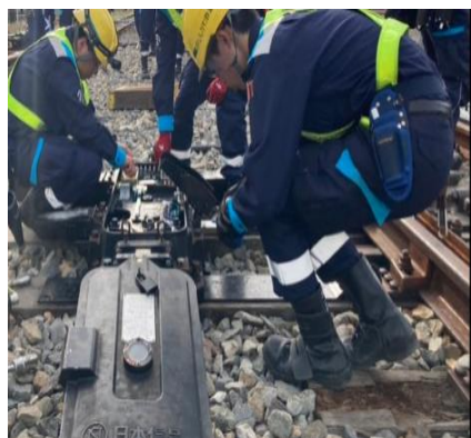
<電気センター錬成道場(訓練)>
