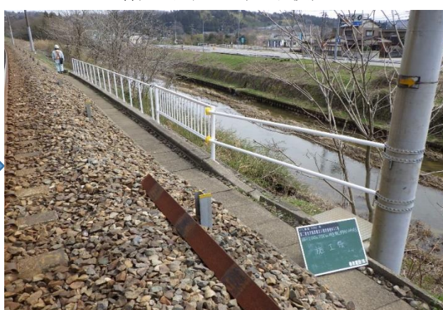
<転落防止柵（工事後）>
