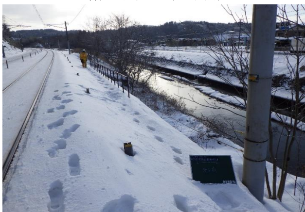
<転落防止柵（工事前）>
