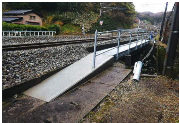
<転落防止手すり（工事後）>
