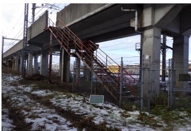
<階段手すり（工事前）>
