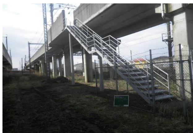
<階段手すり（工事後）>
