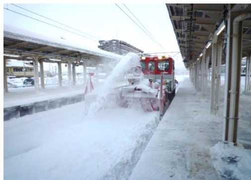
＜MCロータリー車による除雪作業＞
