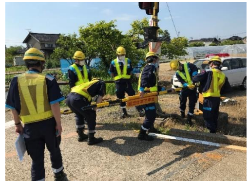
＜遮断桿取替訓練＞
