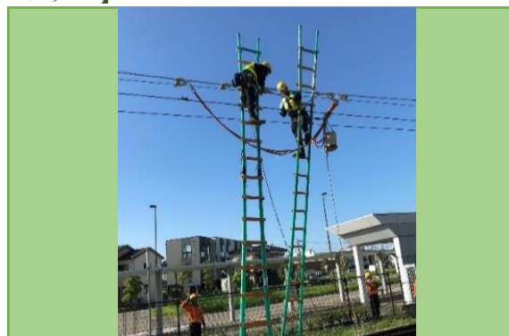
＜トロリ線断線復旧作業＞
